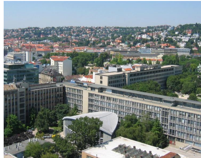
Aula maxima Strojníckej fakulty STU Fotografia z budovy Stavebnej fakulty. Strecha auly má tvar hyperbolického paraboloidu.
